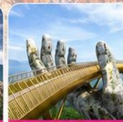
สะพานมือสีทอง
